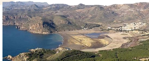
Imágenes de las obras de regeneración de la bahía de Portmán.
